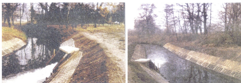
Rys. 1. Komora spustowa kolektora „Olza” do rzeki Leśnicy [1]
